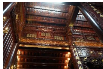
写真 1-1-1-ア-d ベトナム調査 4 ベトナム伝統木造住宅 主屋住宅内部天井
