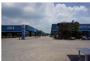
写真 1-1-1-ア-a ベトナム調査 1 木材会社 工場全景
