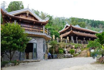
写真 1-1-1-ア-d ベトナム調査 4 ベトナム伝統木造住宅 個人住宅全景
