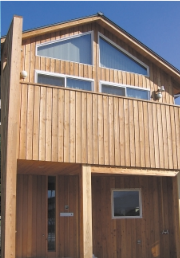
M邸 / 長野県安曇野市・信州カラマツチャンネルサイディング クリアオイルステイン塗装 / O.S.M.O
