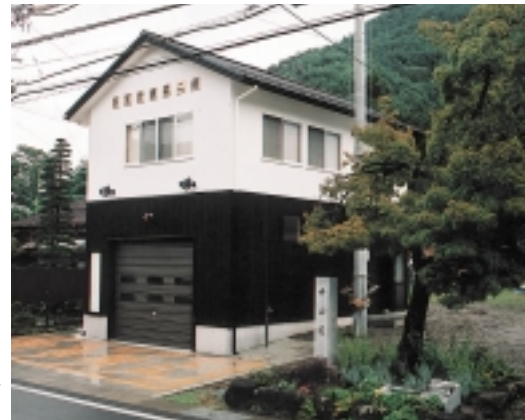
消防団詰所/長野県塩尻市・信州カラマツチャンネルサイディング 着色オイルステイン塗装/キシラデコール
