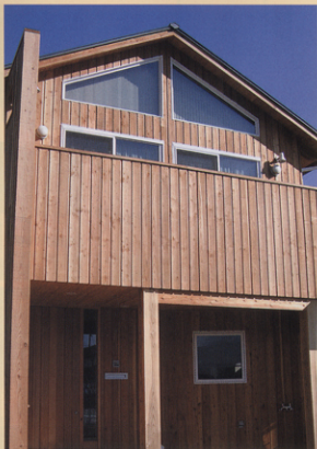
クリヤーオイルステイン塗装による 信州カラマツチャンネルサイディング
