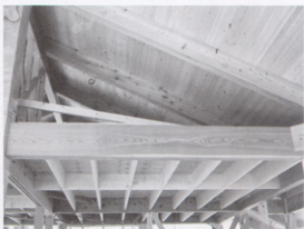
事例内観。2階床梁は公有林の信州カラマツ材の無節梁（120×330×3,640mm）を使っている
