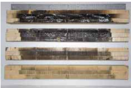
写真-167 試験パネル延焼面抜取り ヒノキ 厚 65mm 1 枚目パネル：上段 3 列 2 枚目パネル：下段 3 列 3 枚目パネル：上段 3 列 4 枚目パネル：下段 3 列
