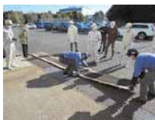
⑩ 試験完了 試験体パネル外部搬出
