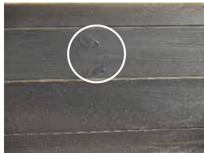
Flaming Drops/火炎落 樹脂(ヤニ)の露出
