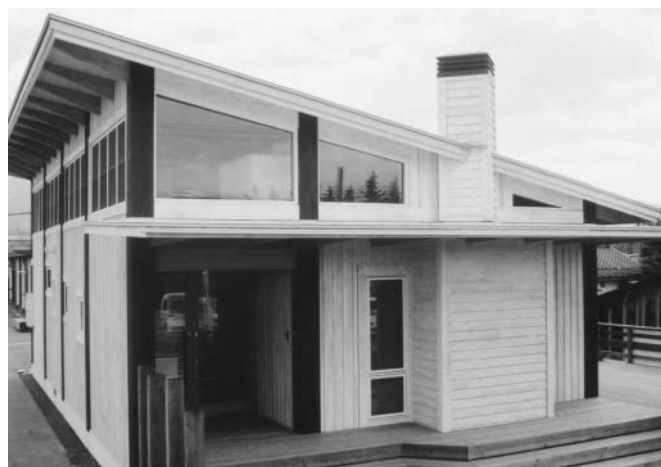
写真12 建物2 信州カラマツ外装材 押え縁 (ボードアンドバテン)
