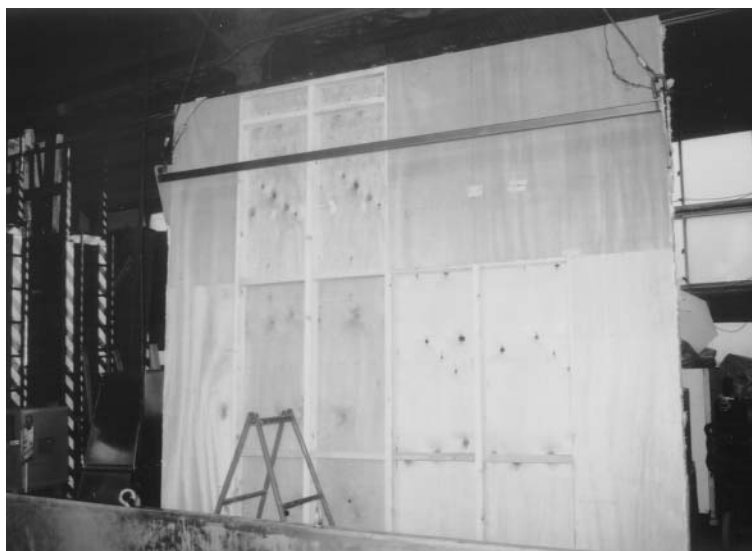
写真6 試験体裏面（壁内部状況）
