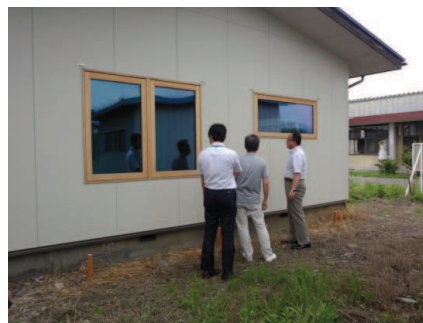
超断熱サッシの取付状況
