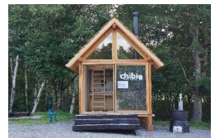
【長野県産木材活用住宅】 チビック I (10㎡) 試作品 外部
